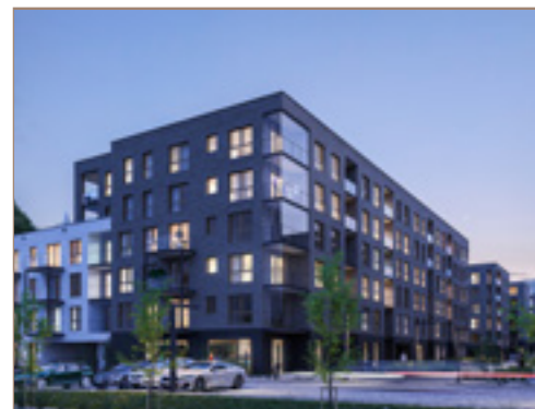
Zajezdnia Wrzeszcz Gdańsk-Wrzeszcz
